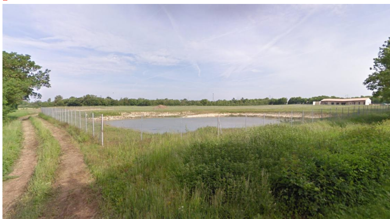
Figure 39 : Le bassin de rétention existant B2 collectant les eaux du bassin versant n°2
