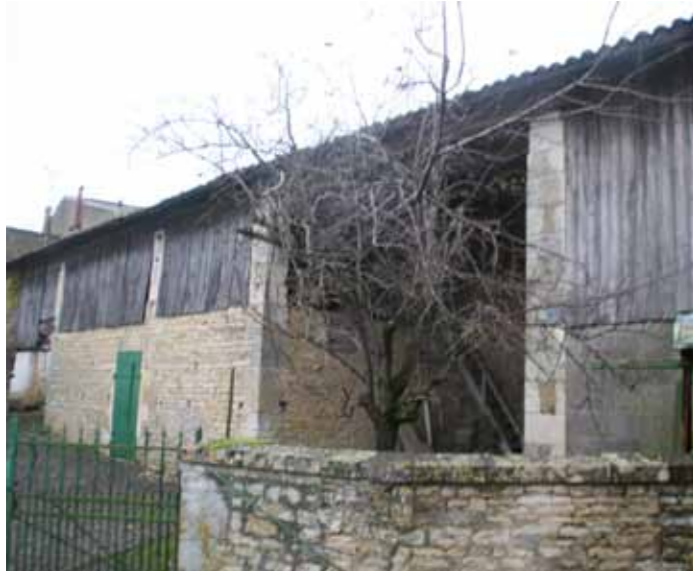
Bâtiment agricole de qualité en bon état
