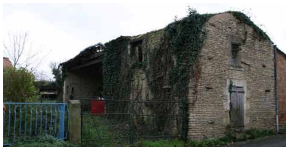
Bâtiments agricoles abandonnés
