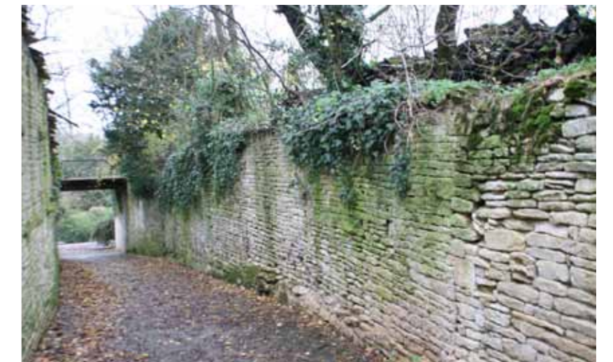
Mur, muret et grilles à conserver
