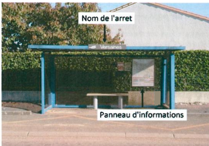
Figure 36 : Photo d'un abri bus de la CAN – Vue de face
