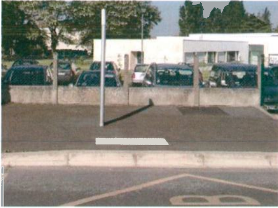
Figure 64 : Photo d'un arrêt équipé d'une bande podotactile au niveau de la montée au bus (arrêt Goise - Niort)
