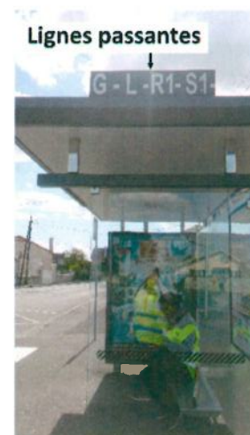
Figure 35 : Photo d'un abri bus de la CAN – Vue de côté
