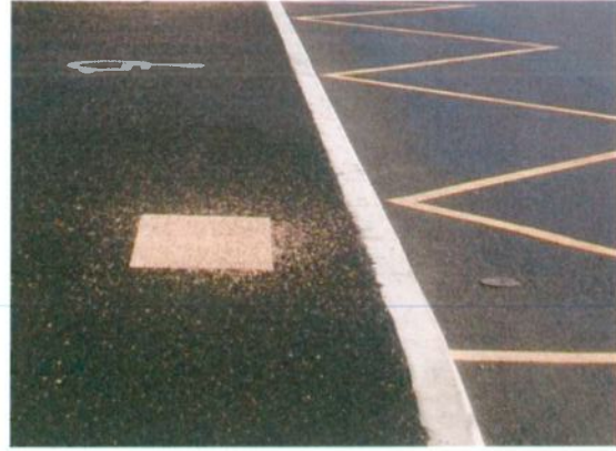
Figure 63 : Photo d'un arrêt équipé d'une bande de résine au niveau de la montée au bus (arrêt Gav Lussac - Chauray)
