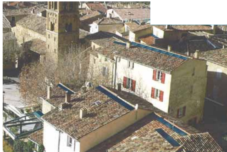
Solution acceptable en bandeaux des panneaux solaires
