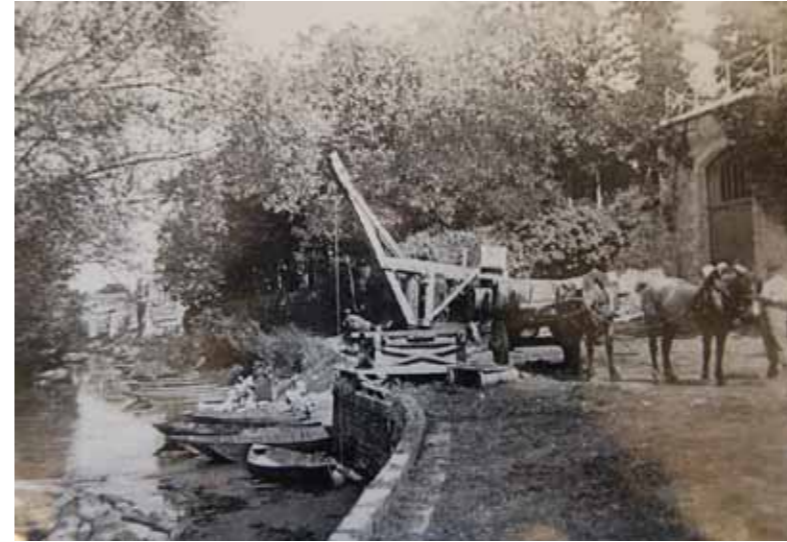
La grue (reconstruite selon un modèle de carte postale ancienne) au bout du quai pour remonter les billes de peupliers de la conche afin de les charger sur des chariots et plus tard sur des camions. Arçais vend du bois (pour les boulangeries et les briqueteries) à toute la Saintonge.
