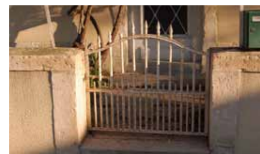
Portillons à hauteur de muret
