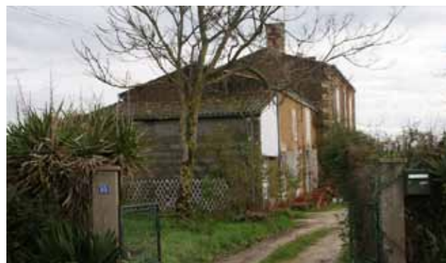
Dépendance à l'Ouest de la façade principale
