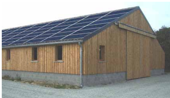
Image 1 : implantation de capteurs sur 100% de la couverture
