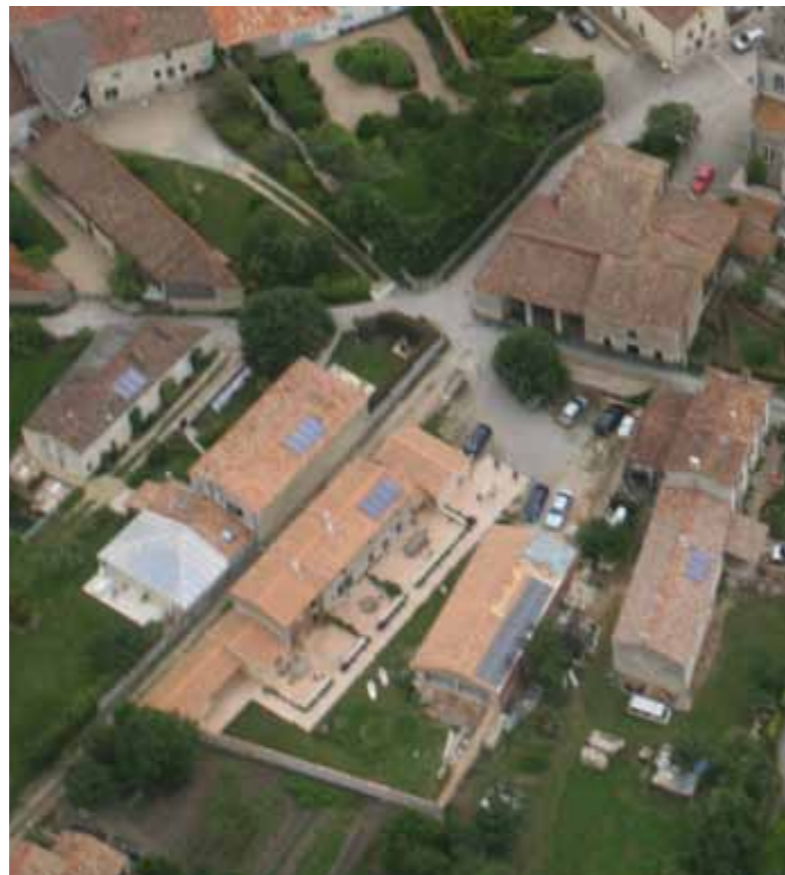
Capteurs solaires implantés assez discrètement sur les toitures du bourg d'Arçais
