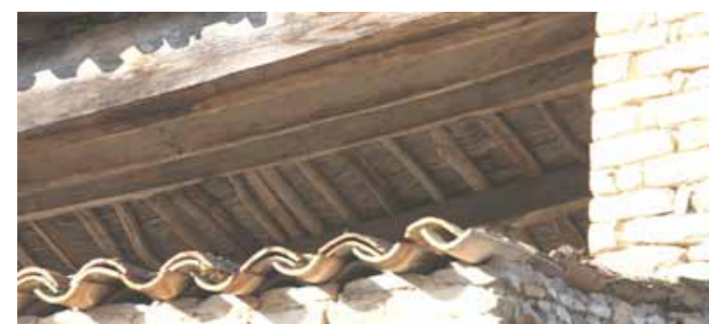
Roseau en support de tuiles
