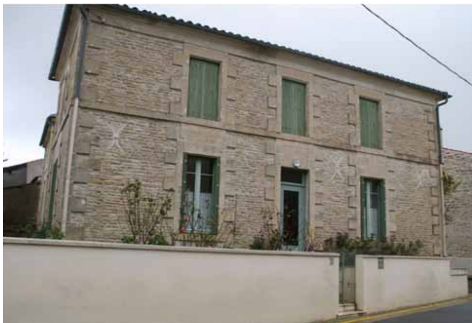
Les murs tels qu'ils sont aujourd'hui.
