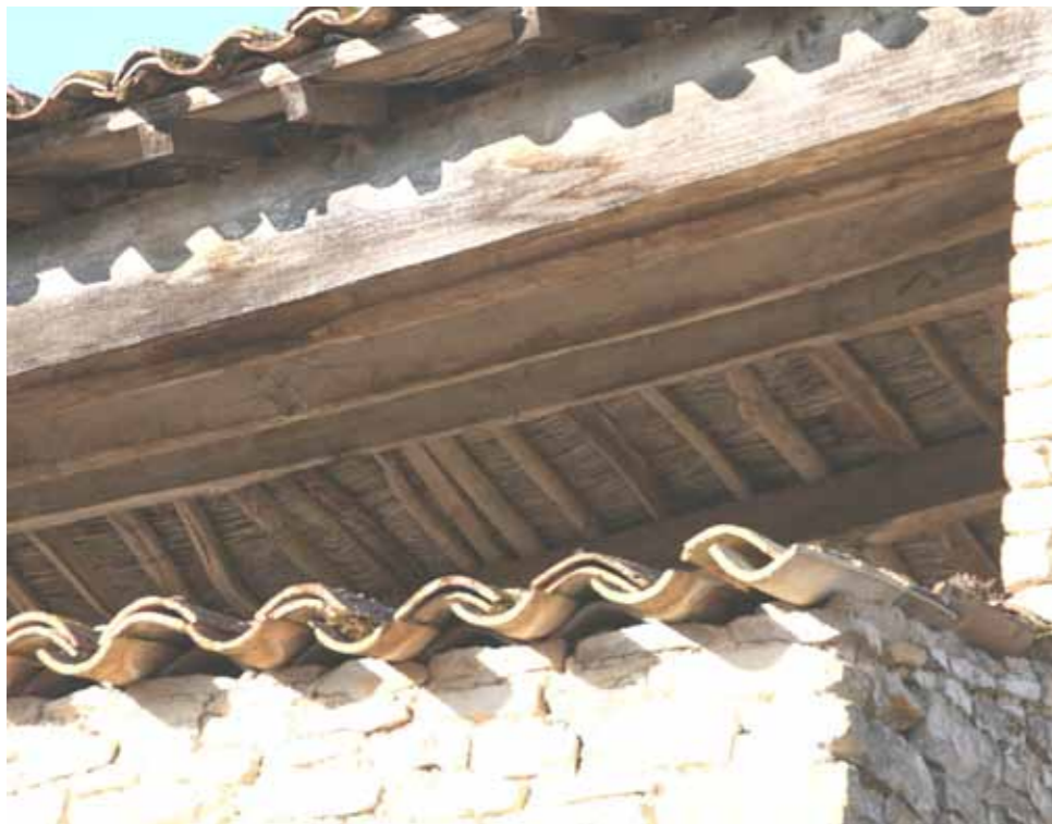
Exemple d'un support de tuiles en roseau et pannes en tronc dégarnis non équarris sur un bâtiment agricole.
