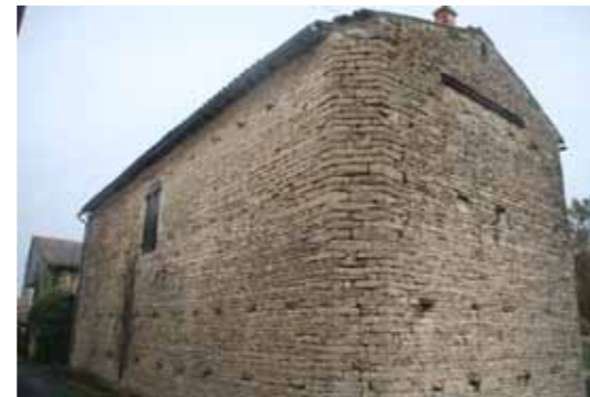
Maisons avec façades Nord et Ouest aveugles
