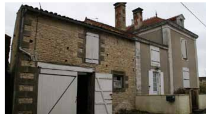
Dépendance au Nord-l'Ouest de l'habitation
