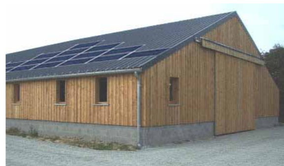
Image 3 : implantation de capteurs de manière morcelée
