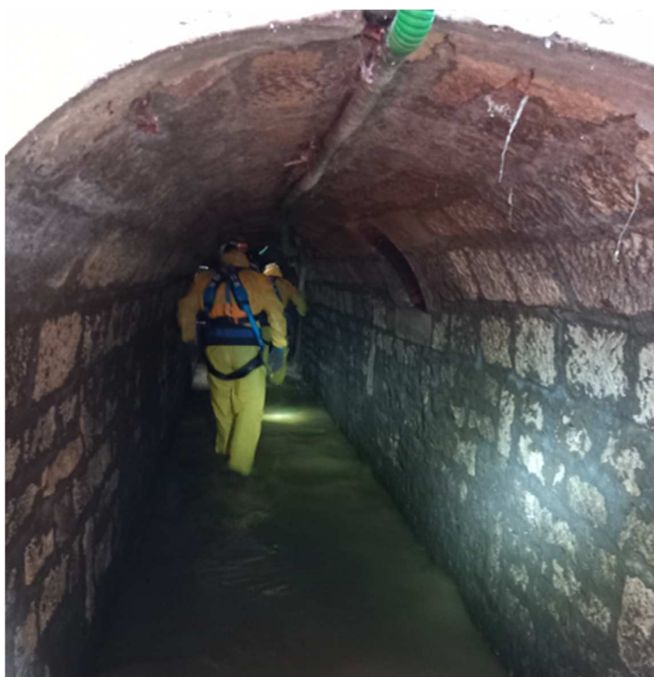
Inspection de l'ovoïde Moulin du Milieu
