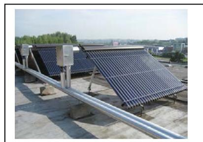
Lorsque les établissements consomment de l'eau chaude en été, il est souvent très intéressant de disposer de solution de production d'eau chaude sanitaire, grâce à des panneaux solaires.
