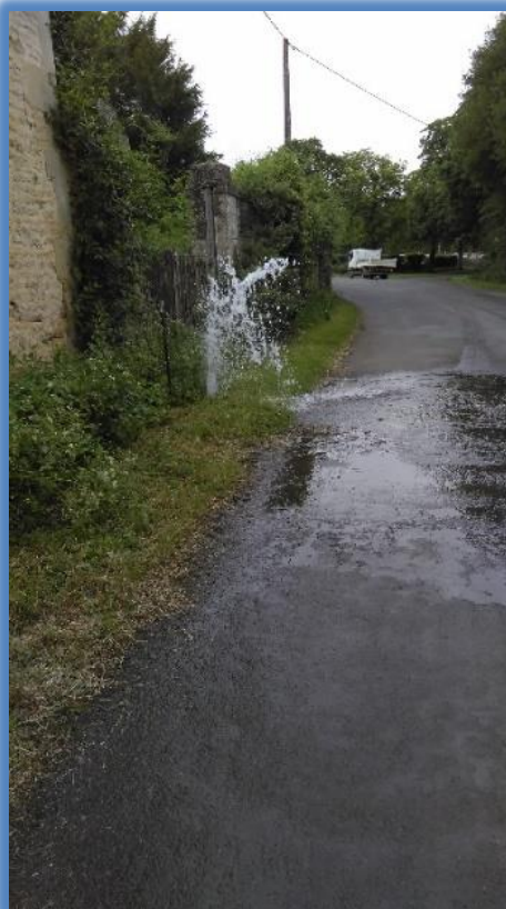
Réalisation d'une purge sur le réseau
