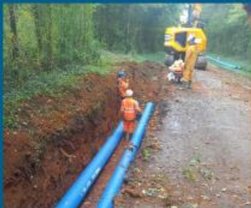
Pose de nouvelles canalisations d'eau potable
