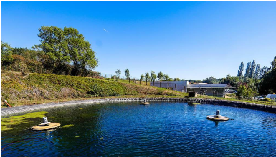
Lagune des eaux de lavage de l'usine de Beaulieu
