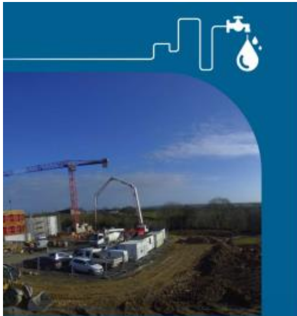
Le chantier en cours à La Véquière (Surin)
