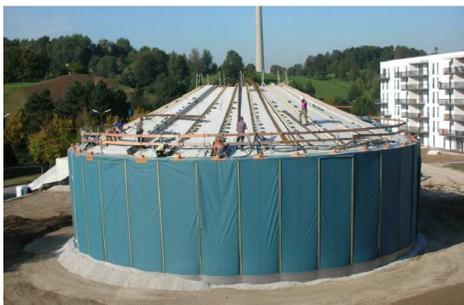
**BTES** : stockage avec sondes géothermiques
