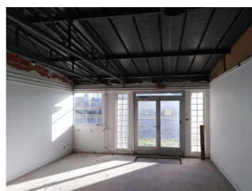
Partie entrée/bureau (pièce de 1 à 23)
